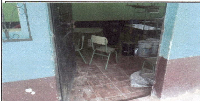
Foto7: instalación de piso cerámico en el aula No.2 del módulo. 2.
