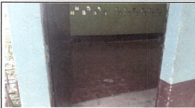
Foto 8: instalación de piso cerámico en el aula No.3 del módulo 2.
