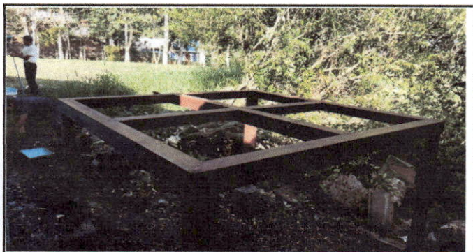
Foto 11: instalación de base de depósito de agua No.1 (tinaco)
