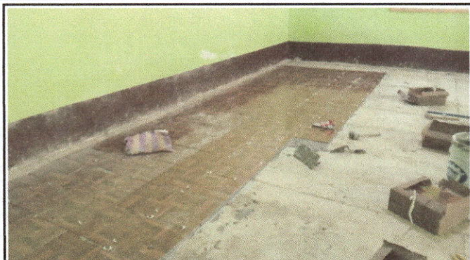
Foto 1: instalacion de piso cerámico en aula No.1 del Módulo 1
