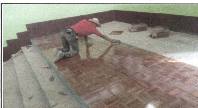
Foto 10: instalación de piso cerámico de las gradas y el escenario del salón de usos múltiples del módulo 1.
