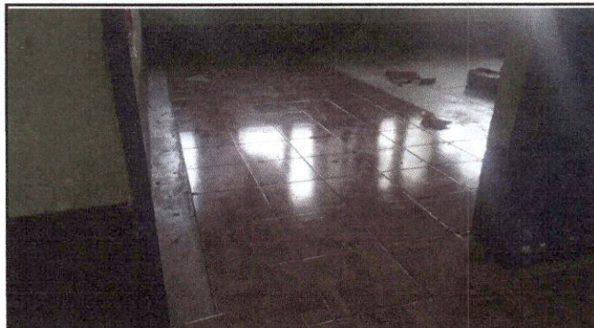
Foto 2: instalacion de piso cerámico aula No.2 del módulo 1.
