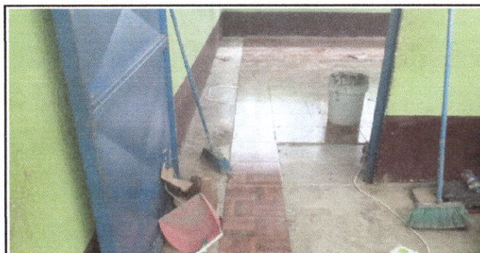
Foto 3: instalación de piso cerámico del aula No.3 del módulo 1.
