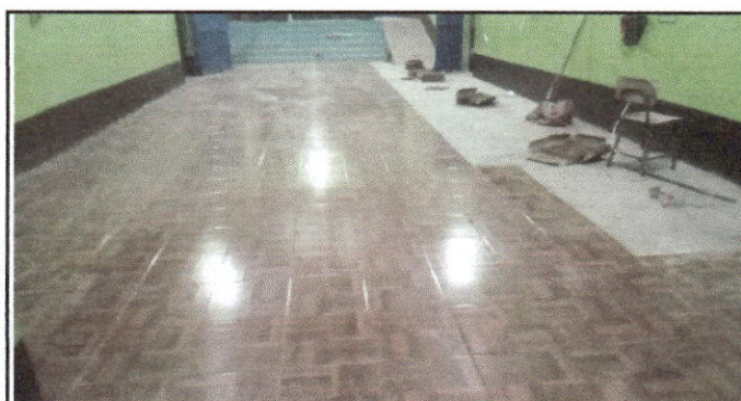
Foto 9: instalación de piso cerámico en el salón de usos múltiples del módulo 1.
